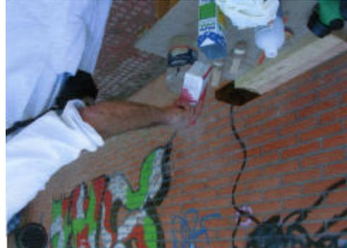
Figura 2. Aplicación del ácido sulfúrico.
